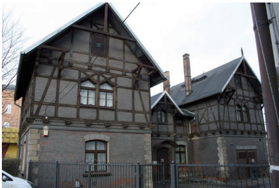
Il.8. Mur pruski w budynku Państwowej Szkoły Muzycznej w Gliwicach, A. Szymanowska-Gwiżdż 2015
