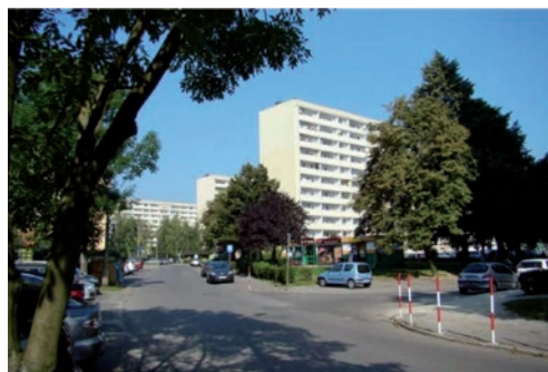
Il.12. Widok budynków osiedla przy ul. przy ul. Żołnierzy Września w Żorach.
