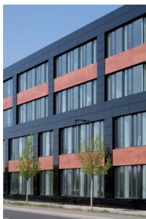
Il. 6 Czarna okładzina ze szklanych modułów CIGS – budynek firmy Sulfrucell w Berlinie Adlershof [13]
