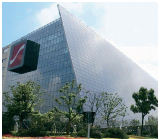
Il. 5 Centrum badawczo-rozwojowe Wuxi Suntech Power, Wuxi. Szklaną fasadę BiPV tworzy 2552 semitransparentnych paneli fotowoltaicznych o łącznej powierzchni 20 000 m 2 . fot. Suntech [5]
