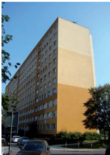
Il.11. Ściana szczytowa budynku.
