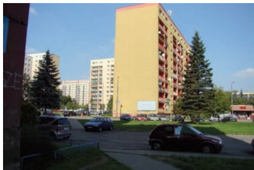
Il.14. Ściana szczytowa budynku.
