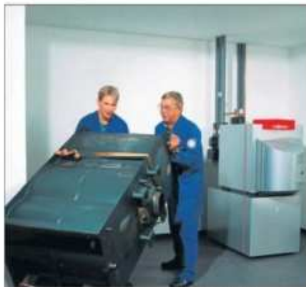
Wymiana starego kotła na nowoczesny, kondensacyjny
