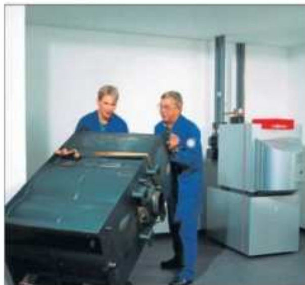
Wymiana starego kotła na nowoczesny, kondensacyjny
